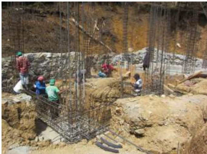
PROCESO DE EJECUCION
