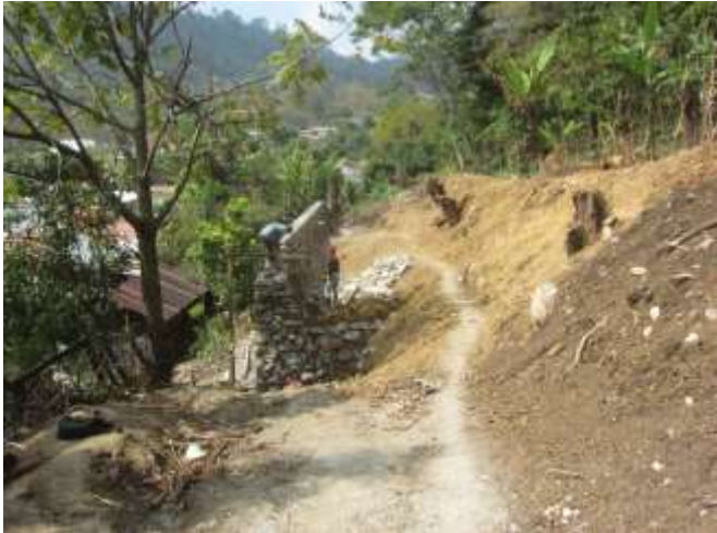
PROCESO DE EJECUCION
