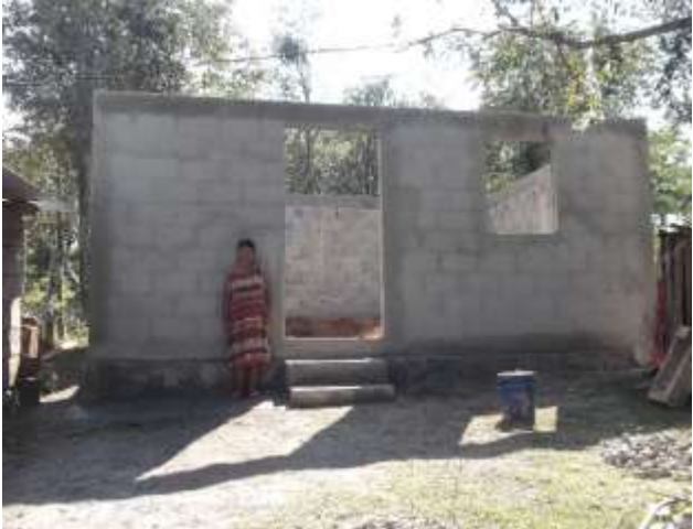
MURO FIRME TERMINADO
