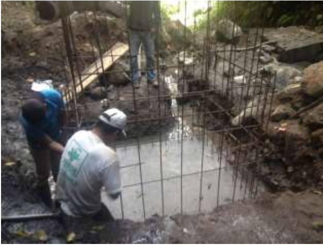
CONSTRUCCION DE CAPTACION
