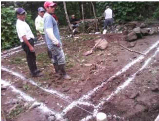
INICIO DE OBRA
