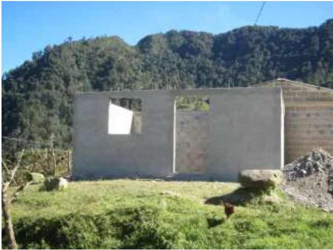
MURO FIRME TERMINADO
