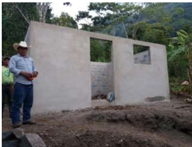
MURO FIRME TERMINADO
