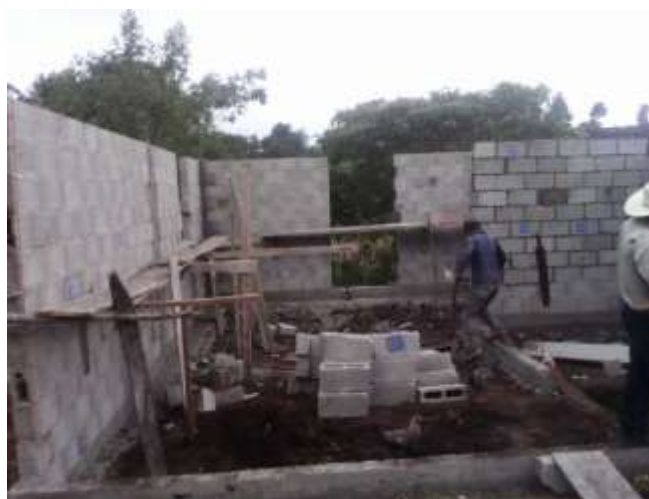
PROCESO DE EJECUCION
