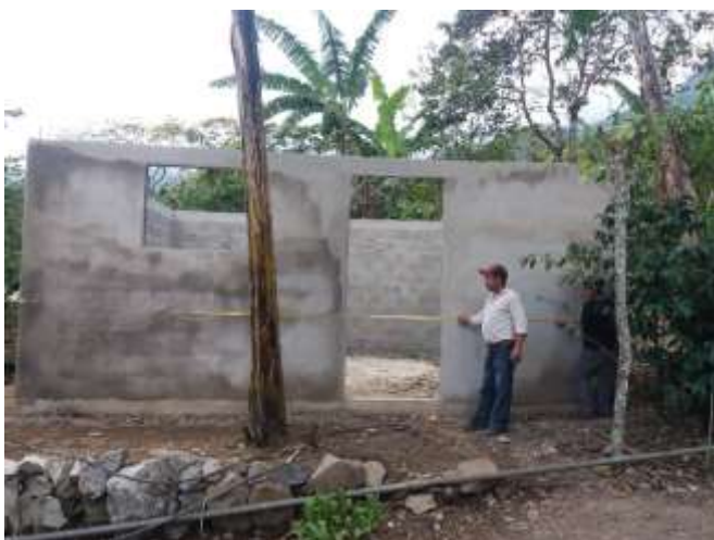
MURO FIRME TERMINADO
