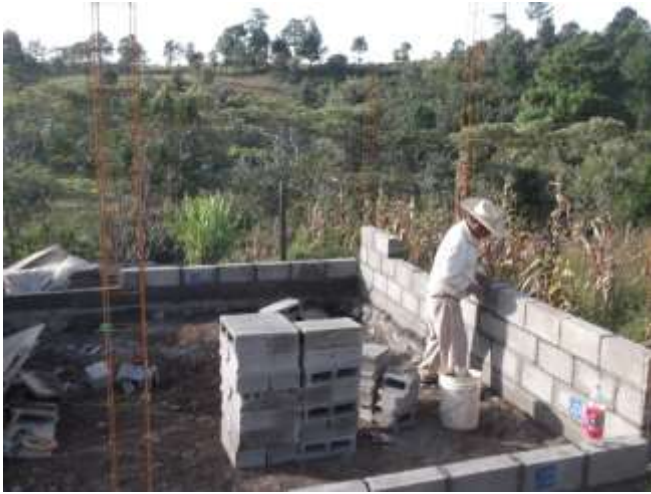
INICIO DE OBRA
