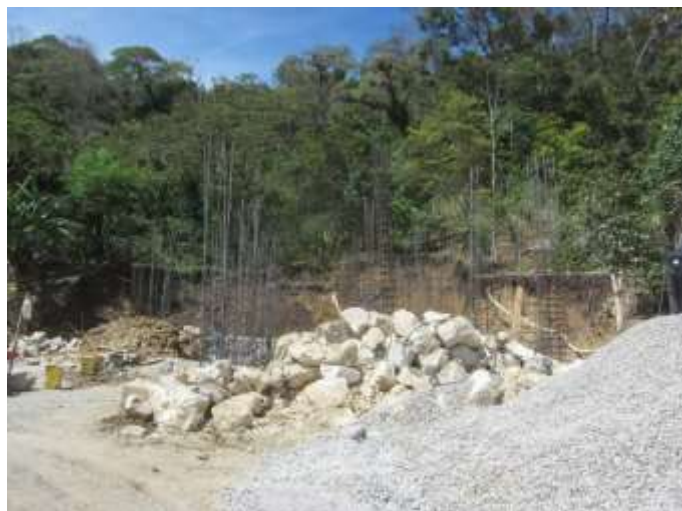
PROCESO DE EJECUCION
