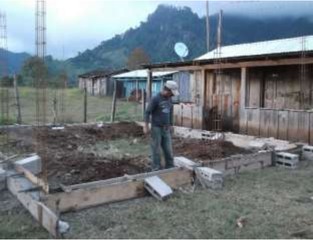
INICIO DE OBRA
