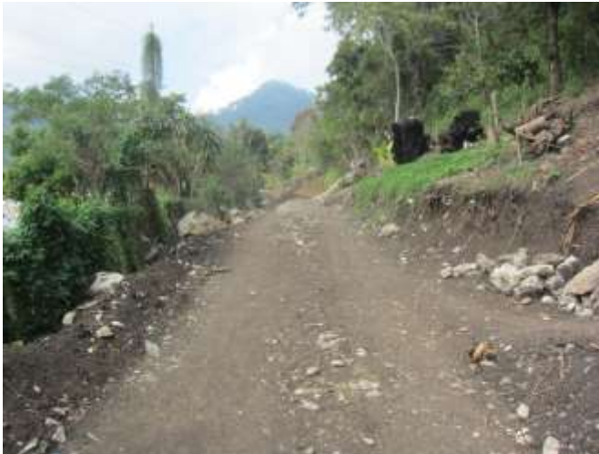
PROCESO DE EJECUCION
