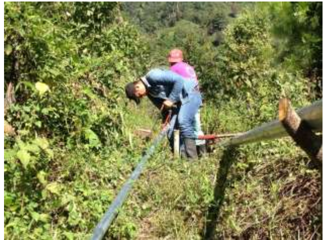
SUMINISTRO Y COLOCACION DE TUBERIA GALVANIZADA DE 2" PULG.
