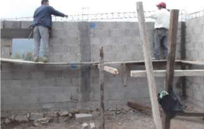
PROCESO DE EJECUCION
