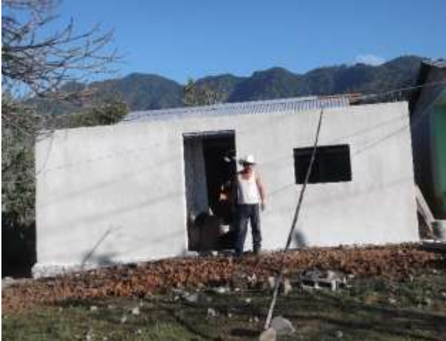
MURO FIRME TERMINADO
