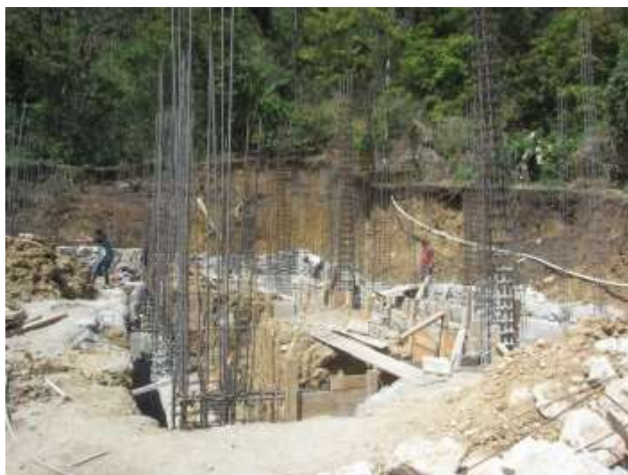
PROCESO DE EJECUCION
