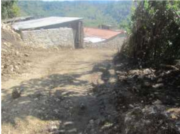
PROCESO DE EJECUCION
